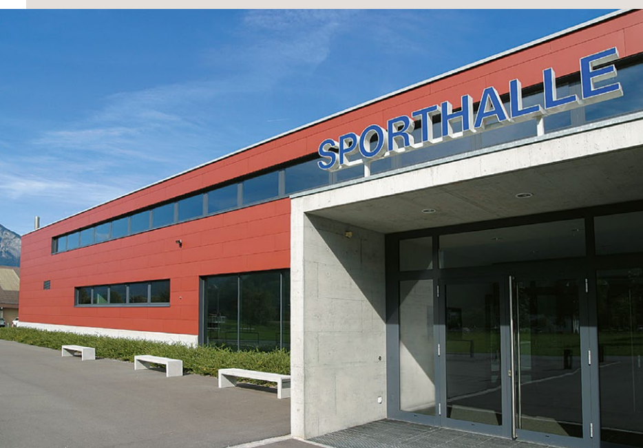
Halle de sport, Bad Ragaz
