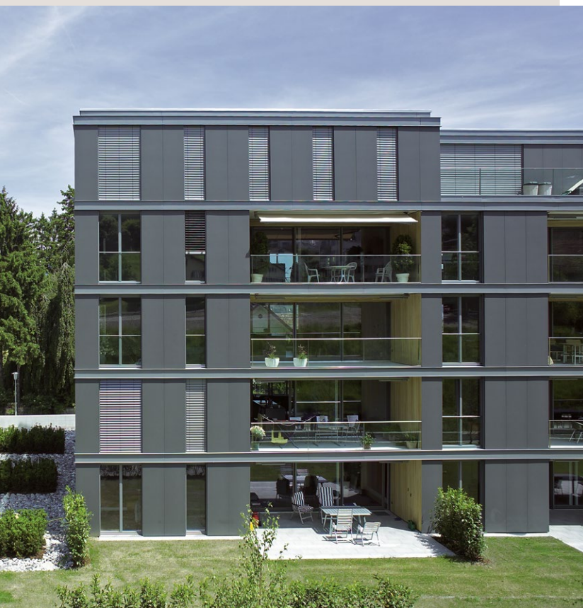
Immeuble résidentiel, Horgen
