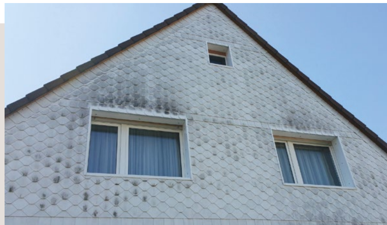
Vor der Fassadenreinigung
