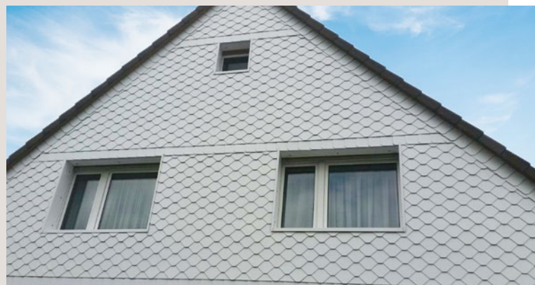
Nach der Fassadenreinigung
