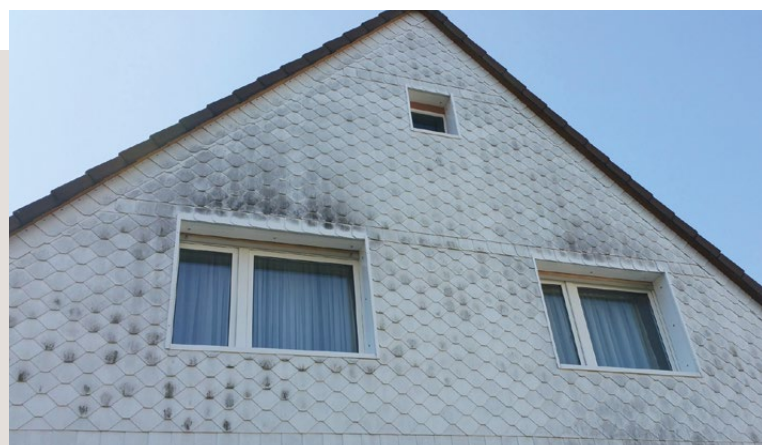
Avant le nettoyage de la façade
