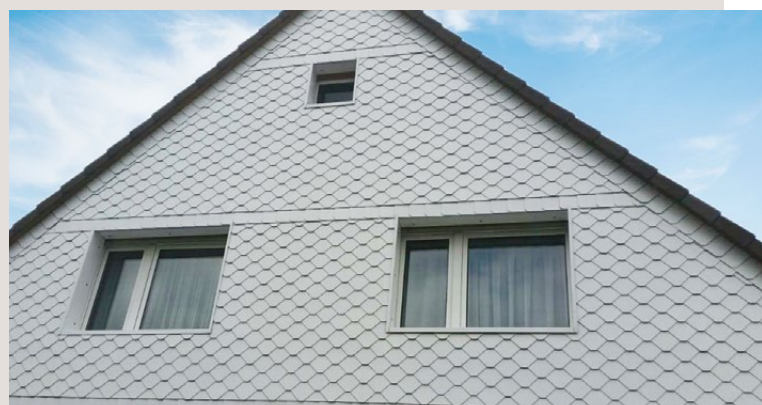
Après le nettoyage de la façade
