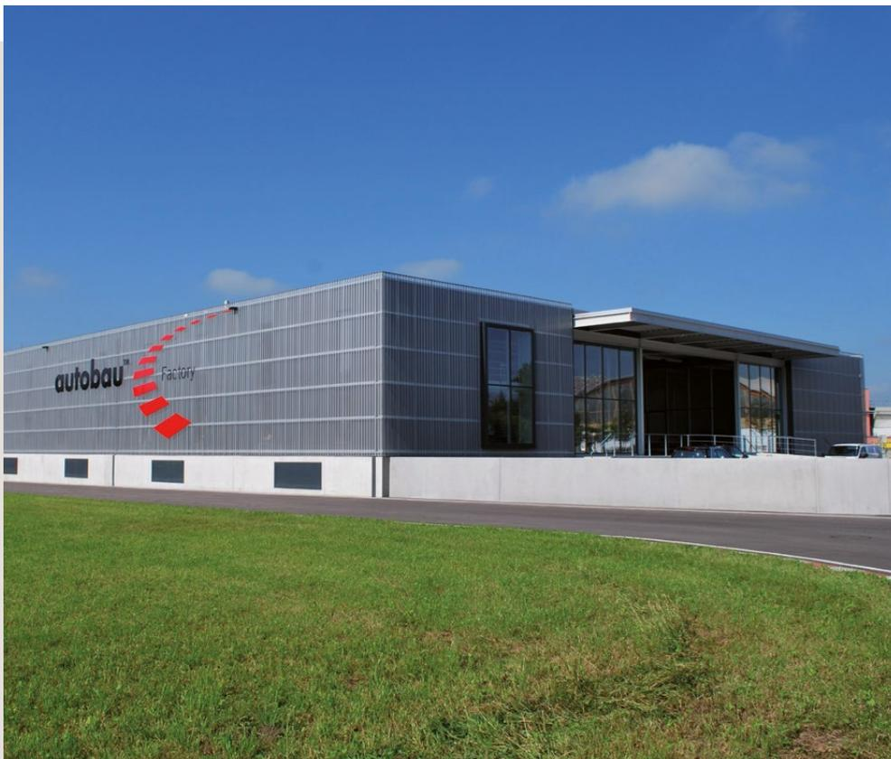
Profils trapézoïdaux perforés
